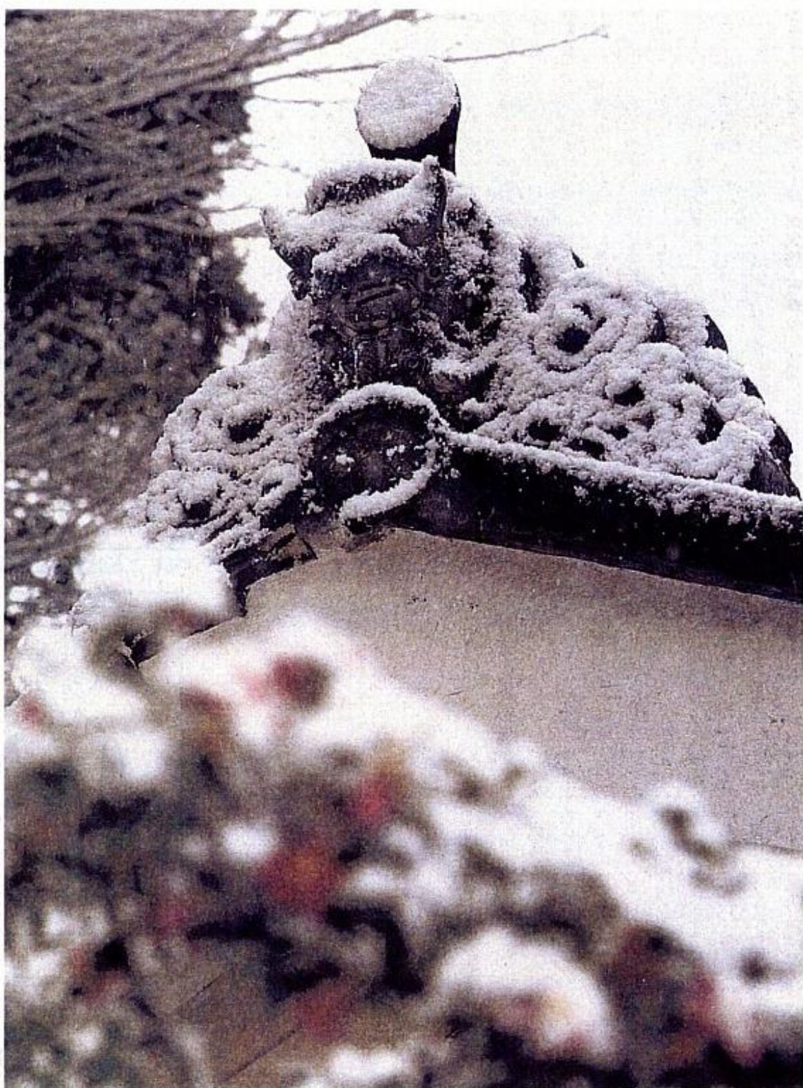
主屋妻側いっばいに載せられている鬼瓦。京風の仕様が表れた造り
