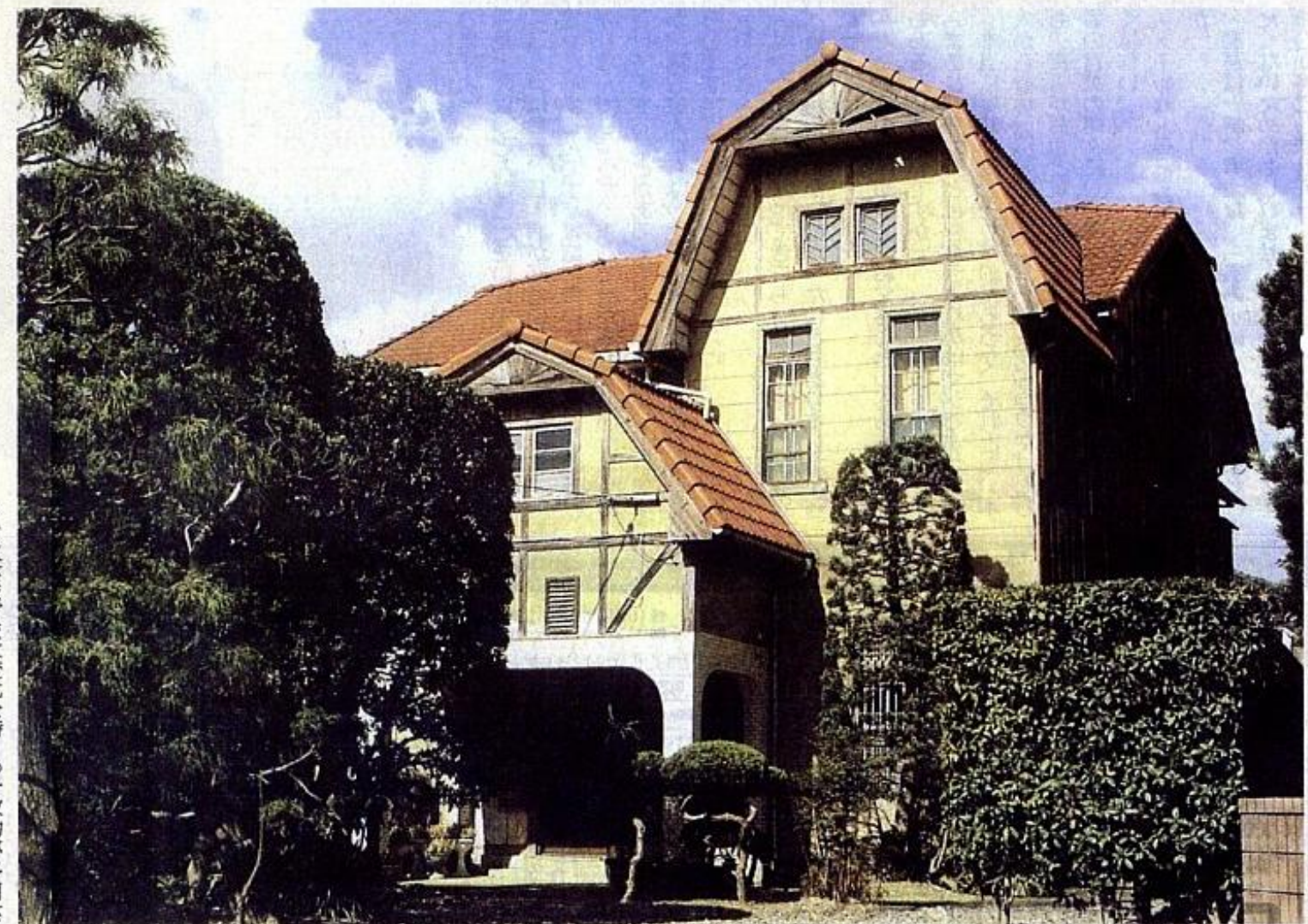
変化に富んだ外観。食い違い2段構えの腰折れ屋根に、上げ下げ窓、ハーフティンバーの外壁
