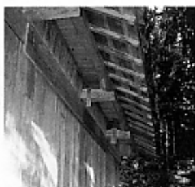
▲延野の農村舞台軒裏。内部から延ばした梁に出桁を通し庇を深くする
