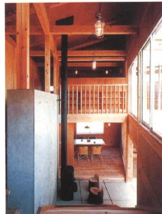
子供部屋のある中2階踊り場より1階の食卓を見下ろす。吹き抜けのあるワンルーム空間は前ストープで覆われ、2階に上がった階段はファンで1階の足元から吹き出す。また、厚いコンクリートの壁はストープで覆われ、蓄熱層の役割を果たす。(岡氏)
