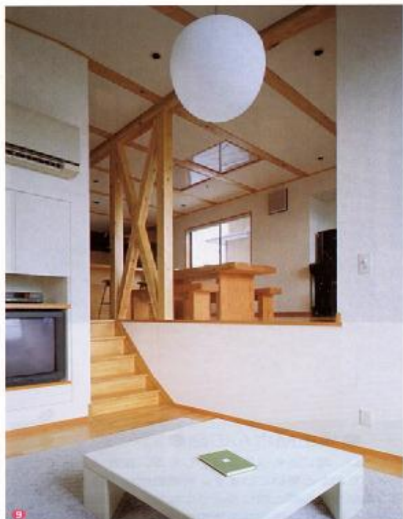
⑨ サロンを家族室からブレース越しに見る。レベル差により仕切られているが、ここだけ3メートルあまりの天井高さがある。 ⑩ サロンから半層分上がった家族室方向を見る。レベル差とさらにブレースにより仕切り感を持たせてある。 ⑪ キッチンが家族室と視界はつながっているがスペースは仕切っている。スタイルは対面式なので会話は可能だ。
