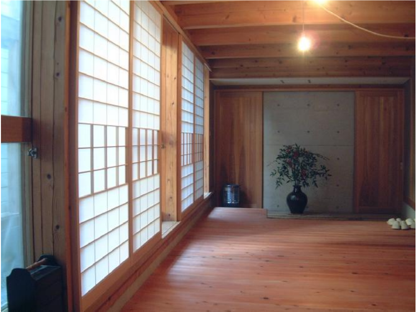
●土間 2 を杉板の床に改修 (2004 年 1 月)
